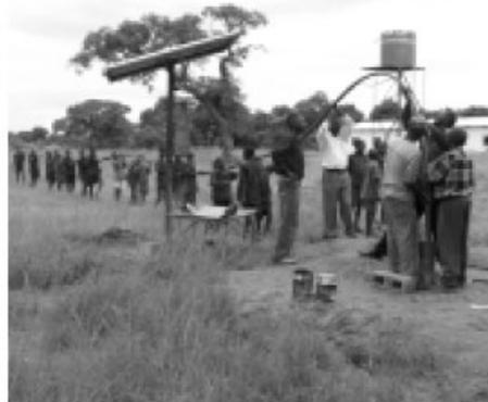
troffen, wie das Aufstellen der Trägergerüste für den 5.000 Liter-Tank und die Sonnenkollektoren sowie die Verlegung von Rohren und Kabeln. Es galt nun, die Wasserpumpe im Bohrloch herabzulassen und samt Steuergerät anzuschließen. Besonders Alfred Göbel sah sich dabei immer umringt von Kindern, die ihm
